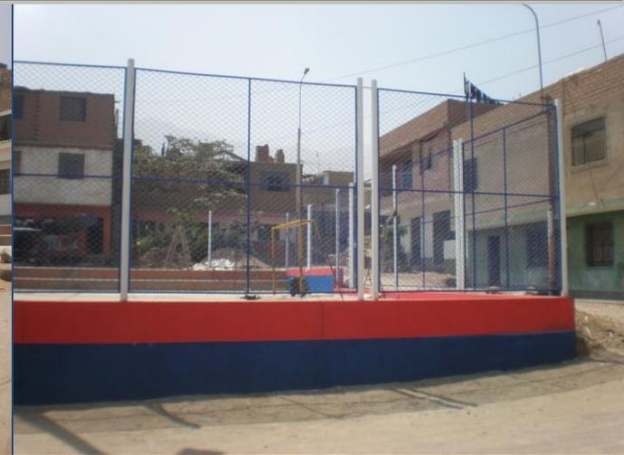
**“CERCO PERIMÉTRICO DE LOSA DEPORTIVA EN LA UCV 87 y 88 ZONA E DE HUAYCÁN, DISTRITO DE ATE- LIMA-LIMA. DE UNA LONGITUD DE 63.61 ML. Y 2 POSTES DE LUZ CON UN MONTO DE INVERSIÓN DE 42 MIL 099.85 NUEVOS SOLES.**
