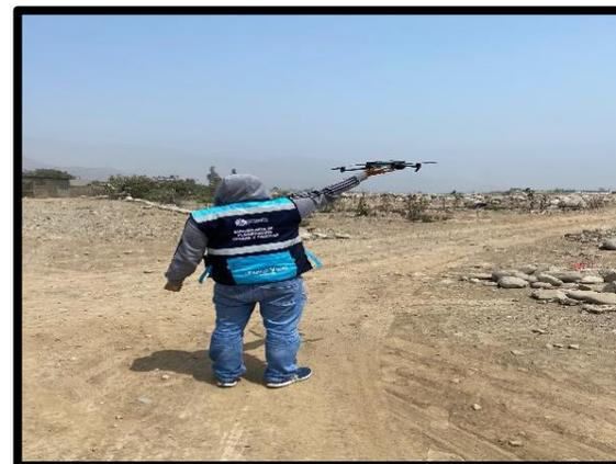
1. LEVANTAMIENTO TOPOGRÁFICO CON DRON
